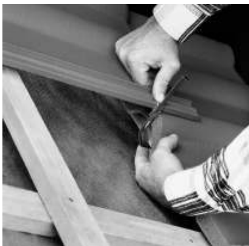
Rys 9. Klamra boczna burzowa uniwersalna Braas
