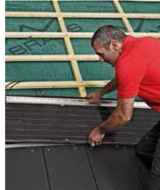
8.8 Montaż paneli PV Premium
