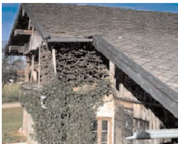
Dach pokryty dachówką cementową z 1844 roku.
