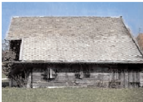
Dach z czasów A. Krohera.
