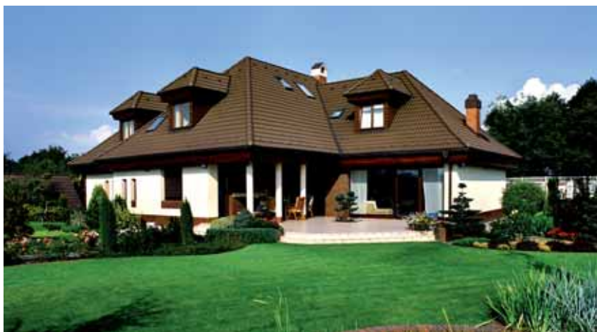
Dach to nie tylko to, co widać
